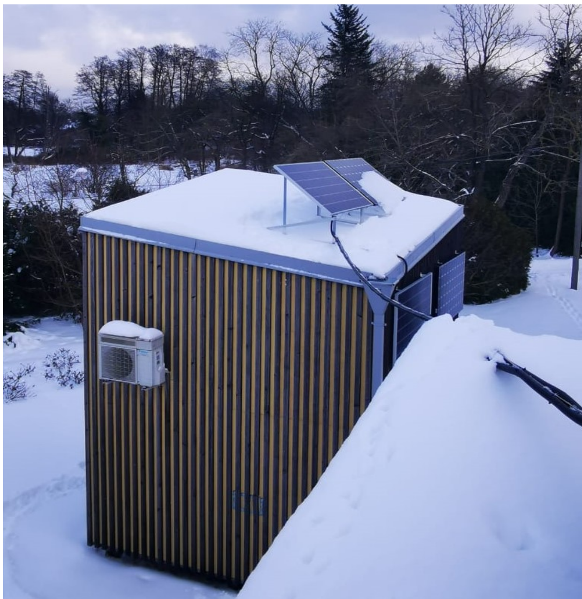
3.2.2 att. Daļēja sniega sega uz D40 saules paneļiem
